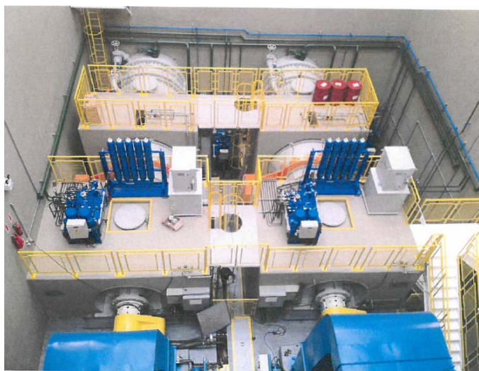
Foto: Casa de força da PCH Rondinha
