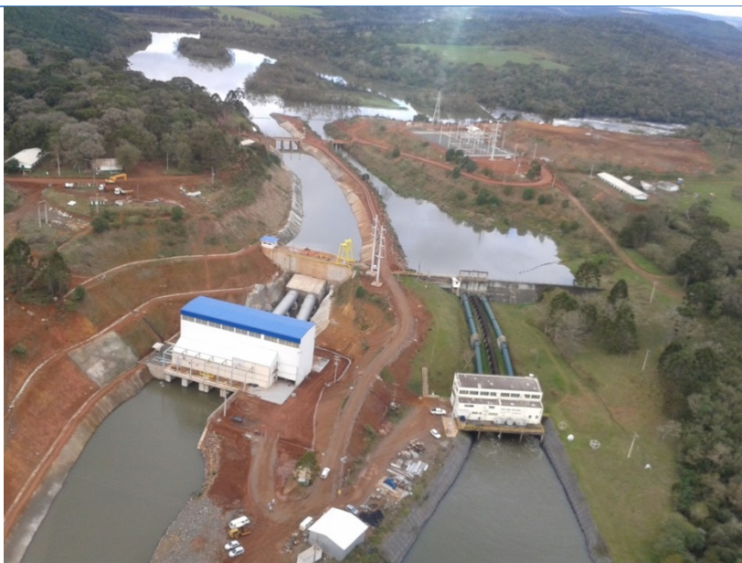
Foto: Ampliação da Usina Pery.
